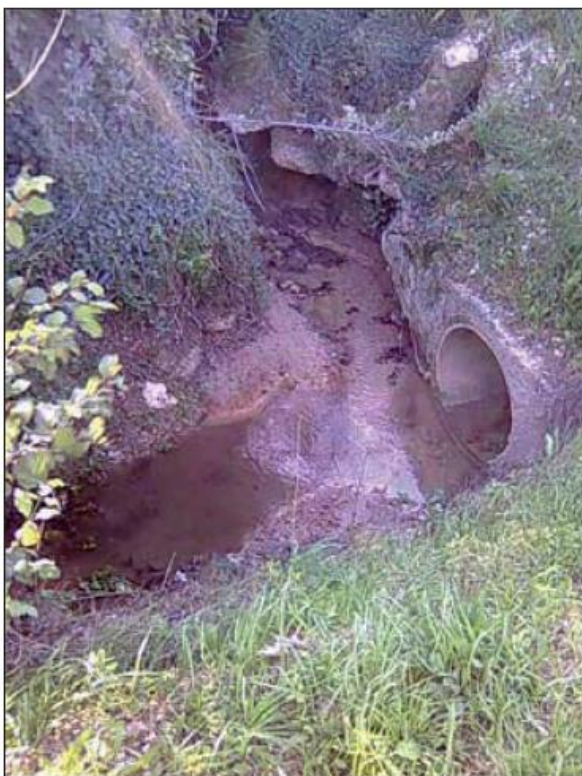
Busage en amont de Cemex (Source : Schéma Directeur d'Assainissement des Eaux Pluviales, Sogréah)
