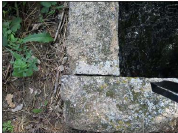
Confluence des Vallats de Pibou et Rayol à Cougnaou - Pont fissuré (Source : Schéma Directeur d'Assainissement des Eaux Pluviales, Sogréah)
