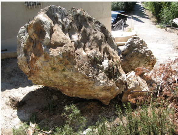
Zone 17 : Blocs éboulés le 20/09/2009 stoppés à quelques mètres de la maison.
